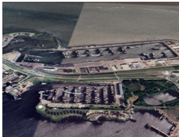
Haven van Lauwersoog (Google Earth)
